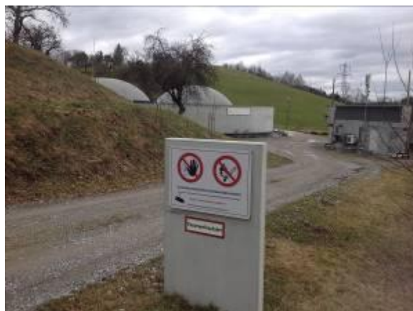
Abb. 10: Beschilderung der Zufahrt einer Biogasanlage (Quelle: Anton Baumann)
