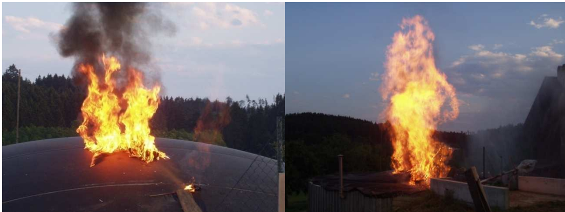
Die Folie ist durchgebrannt, Biogas wird frei gesetzt und brennt ab
